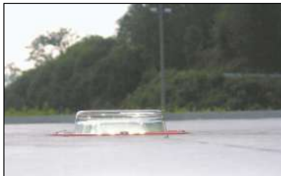
Fot. 2: Widok prawidłowo zamontowanej oprawy dookólnej zagłębionej typu LED.
