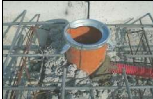
Fot. 1. Widok studni montażowej.
